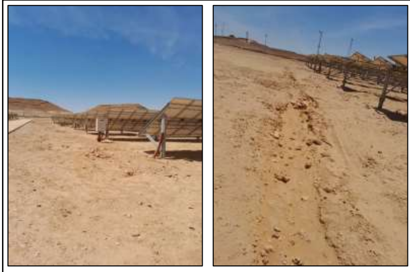
Figure 2.3: Risque de chute de plain-pied
