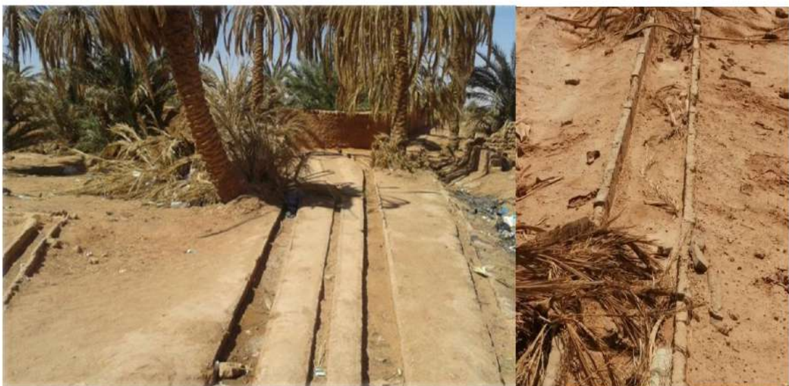
Figure 30: Certains des canaux (Saguias) de la foggara sont remplis de sable
