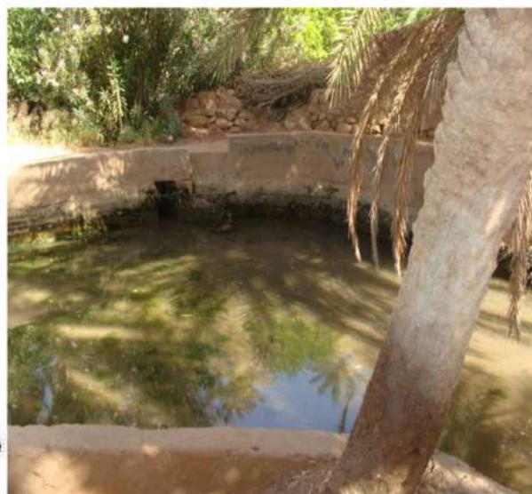
Figure 15: Madjen collectif en béton de foggara de moghrar bechar (Remini, 2013)
