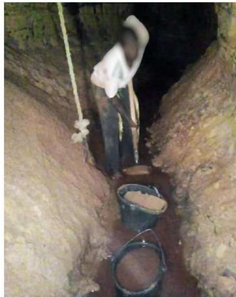
Figure 28: Photo prise lors des travaux d'entretien de la galerie
