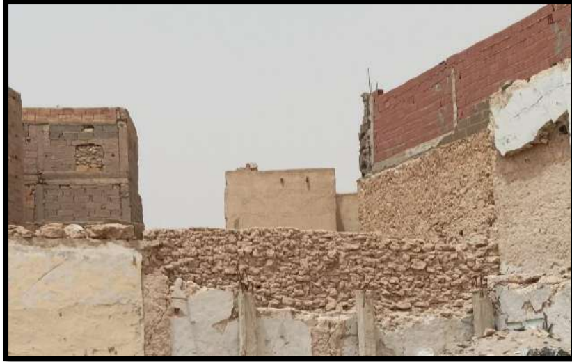
الصورة 9.I ترميم بنايات القصر بواسطة الاسمنت
