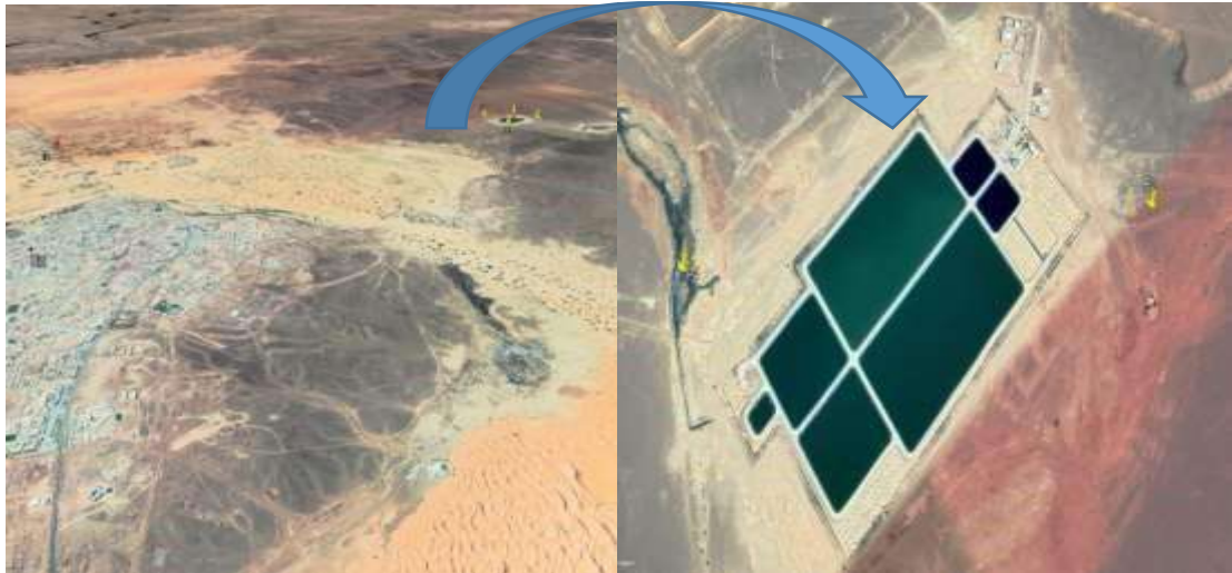
Figure N°17 : Vue de la station d'épuration d'Illizi
