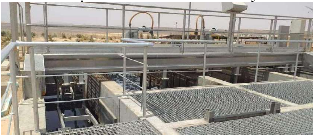
Figure N°20: Dessablage- déshuilage
