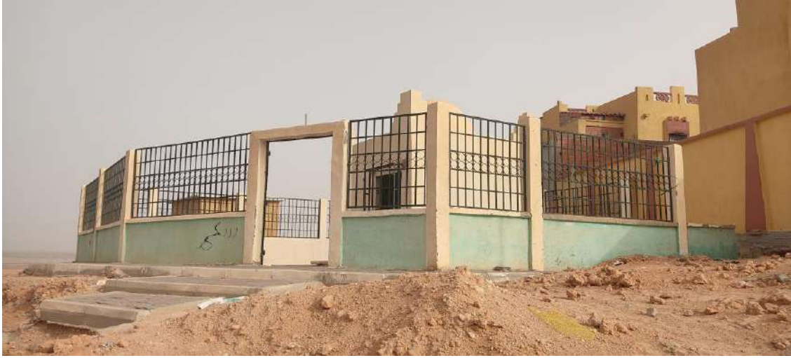
الصورة رقم 08:الواجهة الأمامية لمقام سيدي برجال (إنجاز الطالب)
