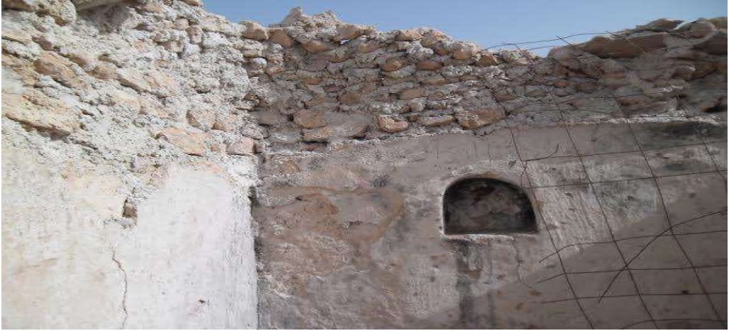
الصورة رقم 01: إحدى الجهات الداخلية لمقام سيدي مبارك (صورة قديمة)
