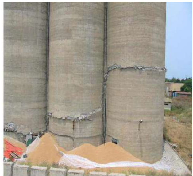
Figure 2.27 : écrasement du béton. [13].
