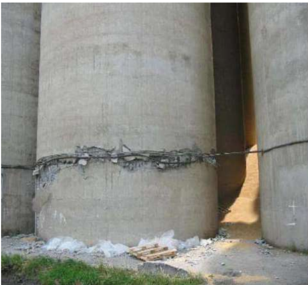
Figure 2.27 : écrasement du béton. [13].
