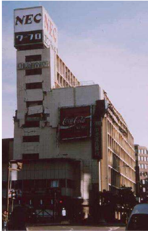
Figure 2.5 : Dommages dans les angles rentrants dans le plan vertical dus aux oscillations différentielles (séisme de Kobé, Japon 1995) [13].
