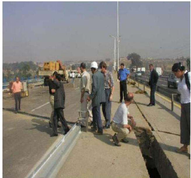
Figure 2.25 : déplacement latéral d'une travée -Pont EL HARRACH. [13].
