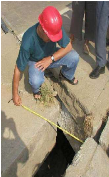
Figure 2.25 : déplacement latéral d'une travée -Pont EL HARRACH. [13].
