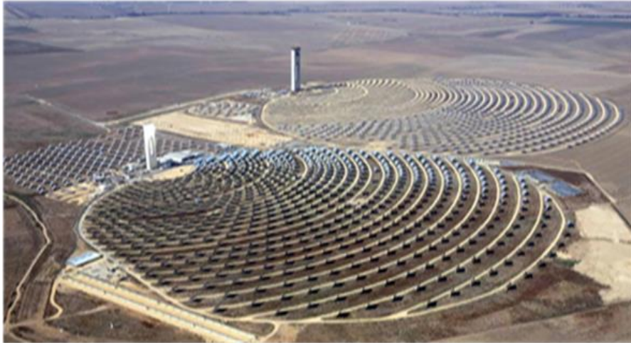
Figure I.9 : Centrale PS10 au premier plan et Centrale PS20 au second plan [11].
