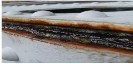
الشكل (7.I): صورة للتآكل الاختياري
