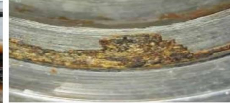
الشكل (8.I): صورة للتآكل الشقي
