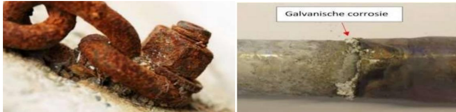
الشكل (1.I): صورة لتآكل الغلفاني
