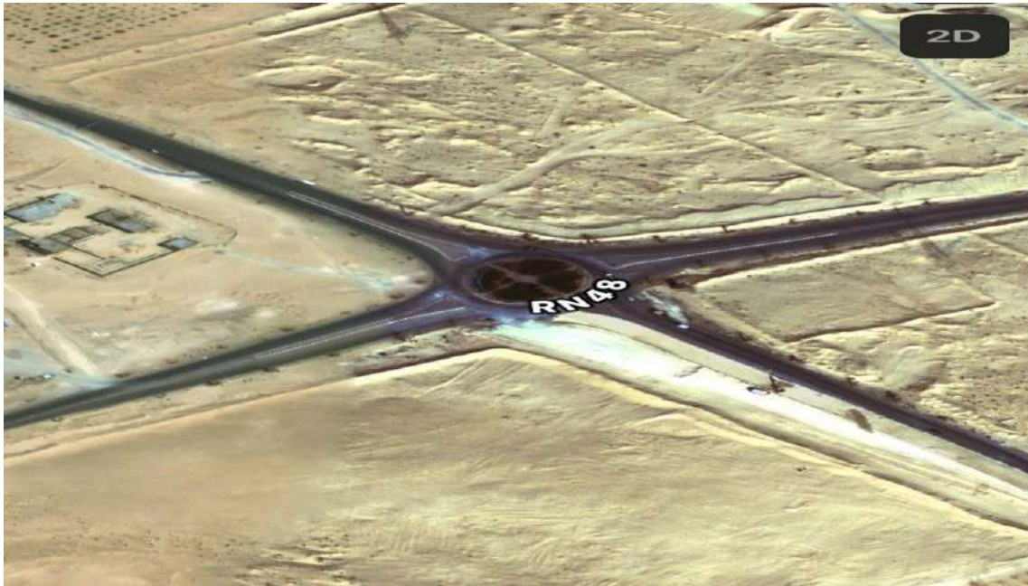
Figure IX .1 Carrefour existant (RN48-accès à à DJAMAA-TALB ARBI-ELOUED-BISKRA )
