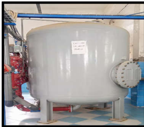
Figure III.11: Filtre à sable.
