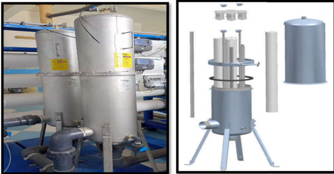
Figure III.13: Filtre à cartouches multiples.
