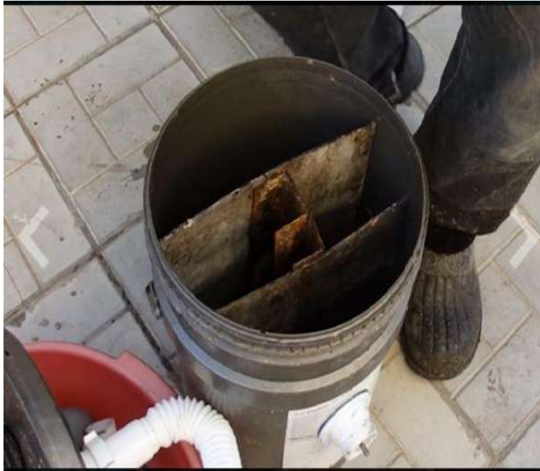
الشكل: مصيدة الزيوت و الشحوم منزلية الصنع
