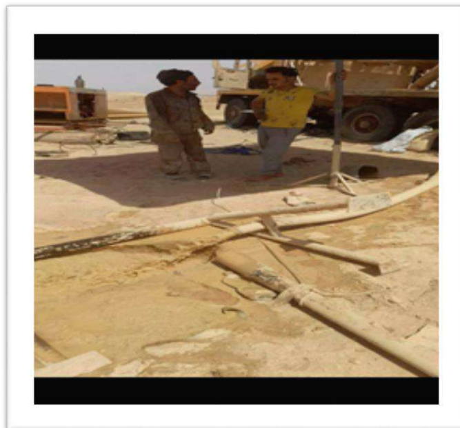
Photo 21: Développement à l'air lift ou compresseur . mars – 2023.
