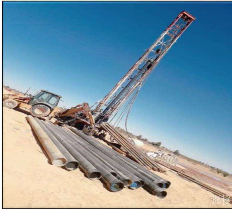
Photo 1: Le mât de forage. [5]
