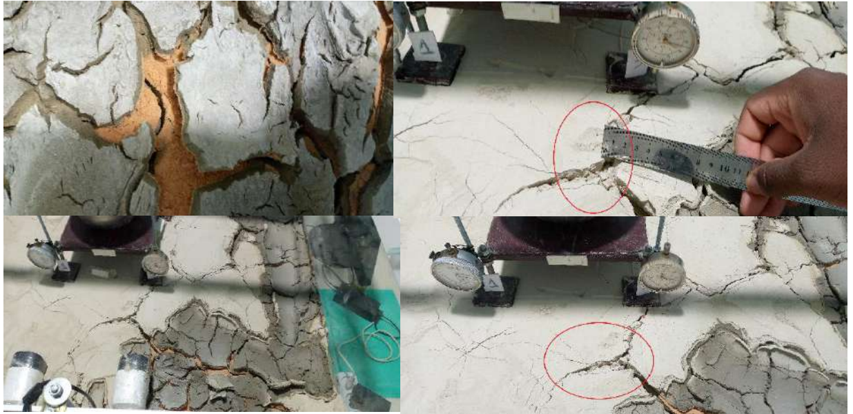
Figure (IV.4) : Formation des fissures de 1 à 2 cm d'épaisseur sur la surface et en profondeur.
