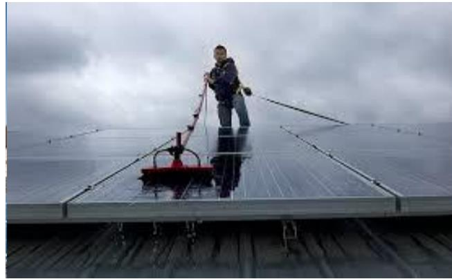
Figure II.2 : Le nettoyage à l'aide d'une aspiration sous vide. [10]
