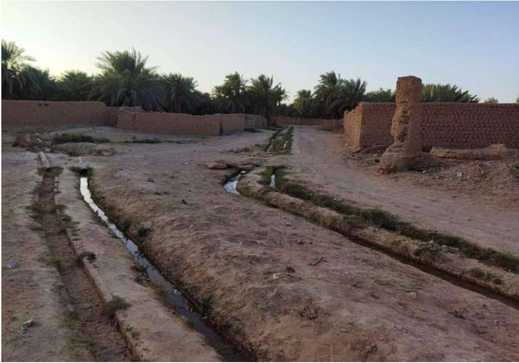
صورة رقم (02) توضح طريقة توزيع مياه الفقارة بمنطقة توات.
