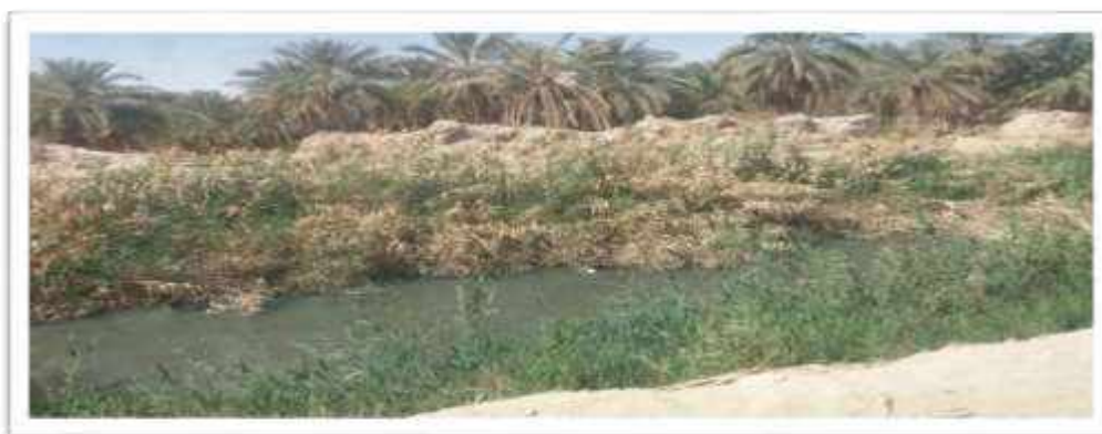
Figure 18: Système de drainage dans la commune de Témacine
