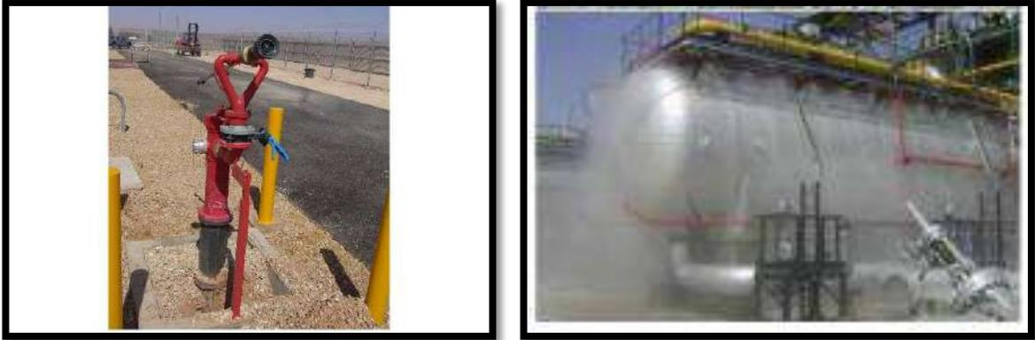
**Figure 2-1 :** Lance monitor connectée sur le réseau maillé enterré [16]
