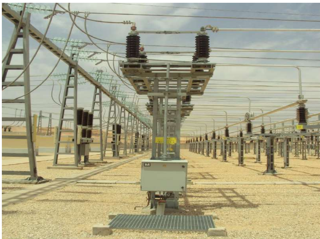
Sectionneur de barre 60 KV
