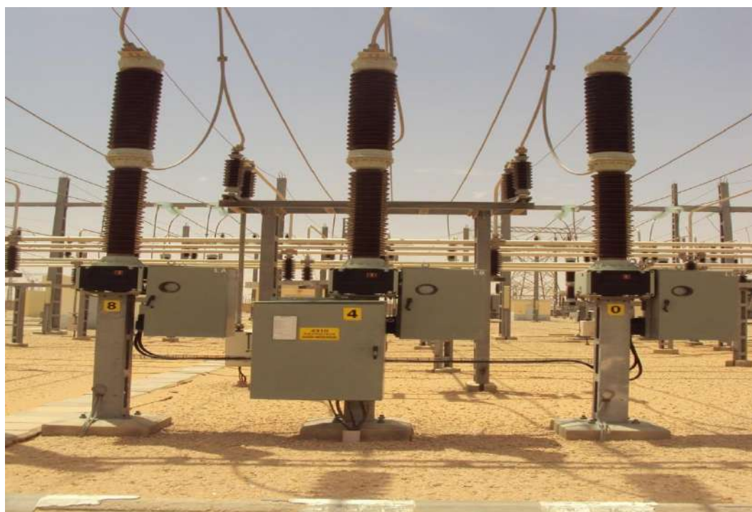
Disjoncteur 60 kv (mono) a commande mecanique
