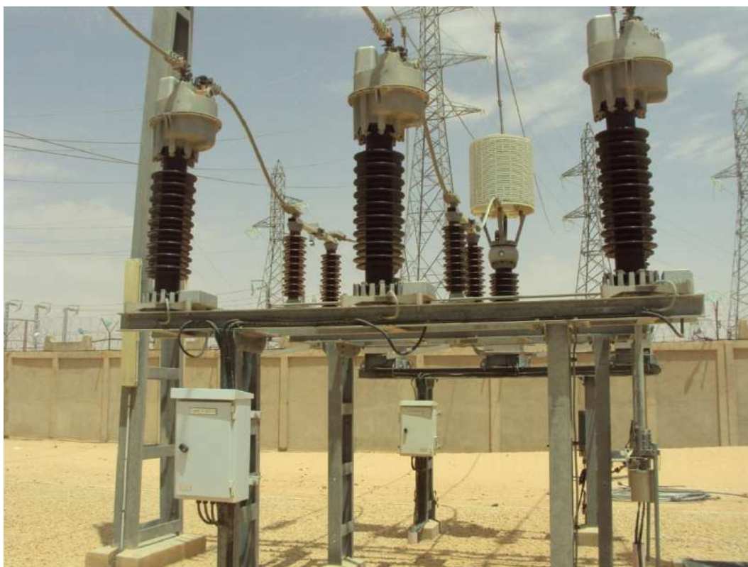
Transformateur de courant (TC) 60 kV
