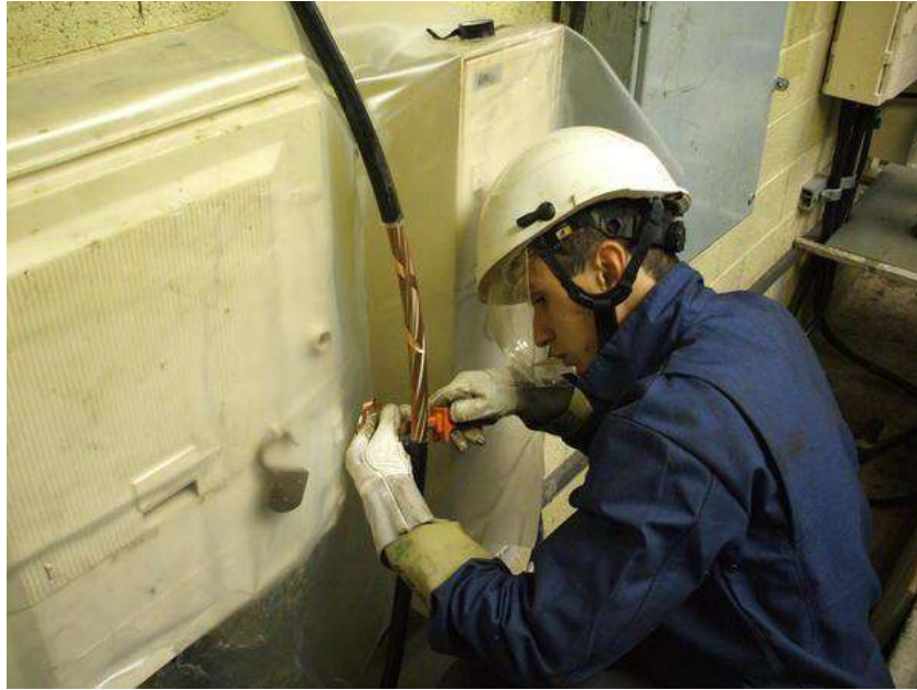
Figure 2.10: travail sous tension dans un sous-sol
