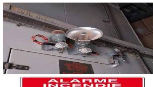
**Figure 13: Signaux d'alarme optique/acoustique**
