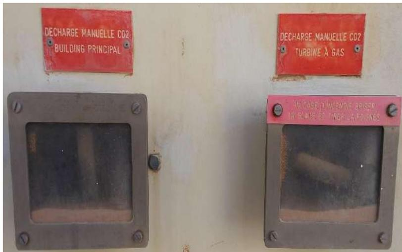
**Figure 16 : Déclencheur manuel TC**
