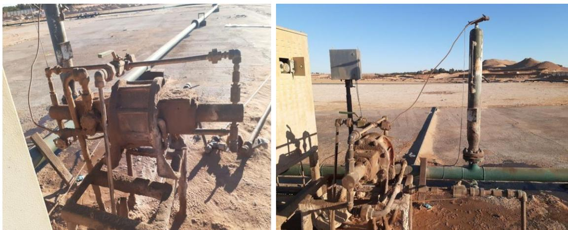
Figure III.1 : La pompe BSB et ses alimentation au gaz
