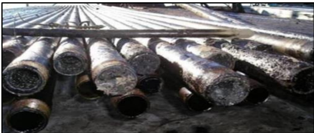
Figure I.16 : Dépôt d'asphaltène dans les tubings de production.
