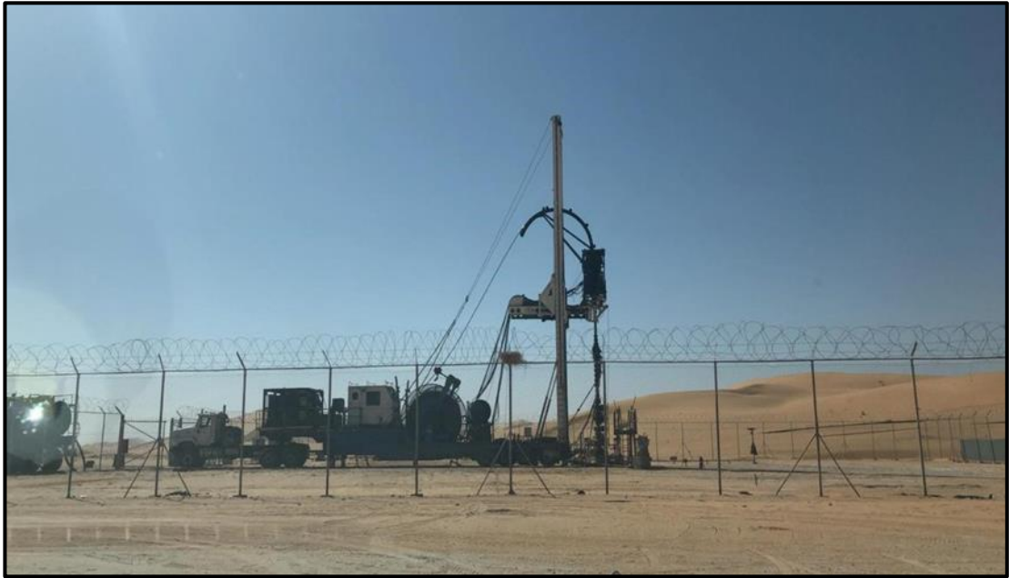
Figure I.18 : Traitement du dépôt d'asphaltène (Coiled tubing opération).
