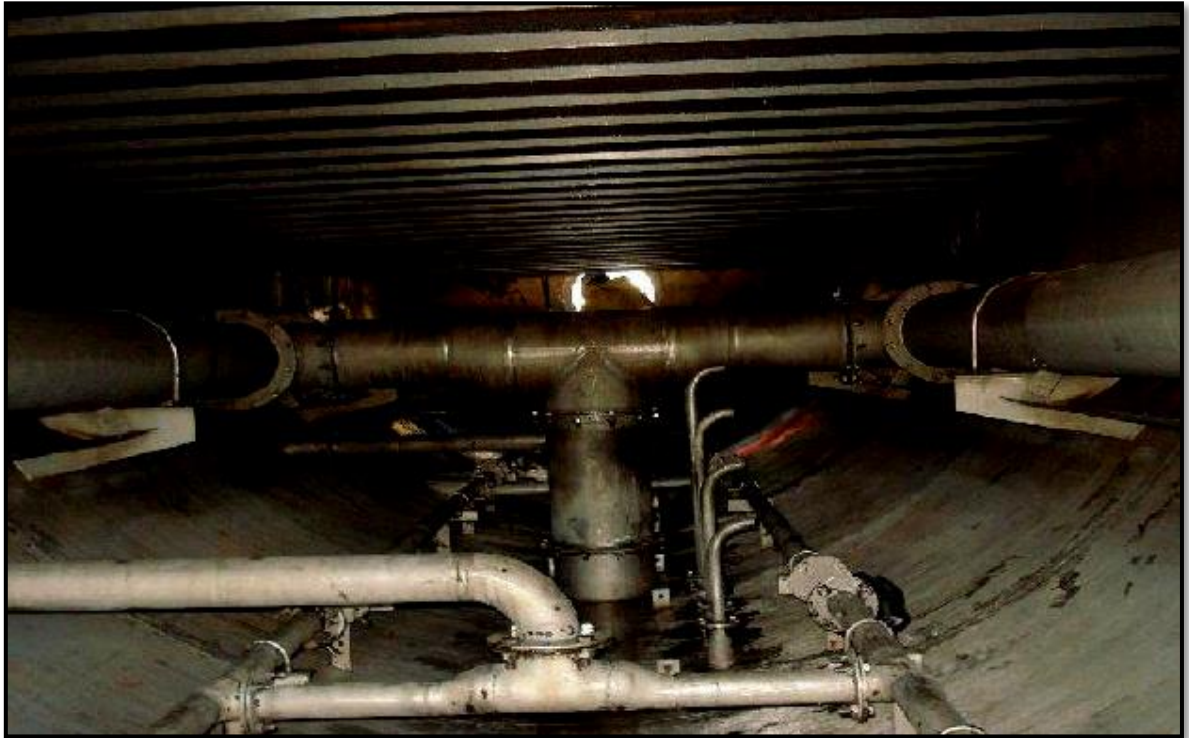
Figure II.10 : Intérieur d'un dessaleur électrostatique.
