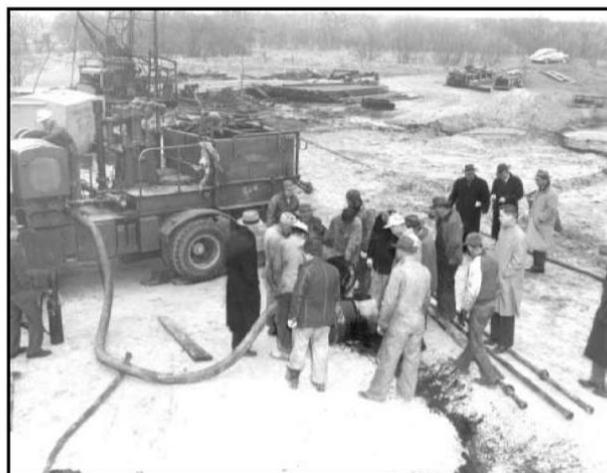
*Figure I.1. Une Fracturation hydraulique précoce réalisée en 1949. [04]*
