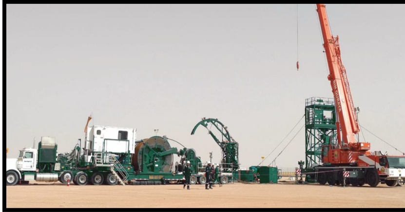
Figure IV.15: Montage avec appareil coil tubing
