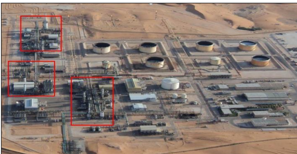
Figure 1.5 : Vue Aérienne de CTH. [*]
