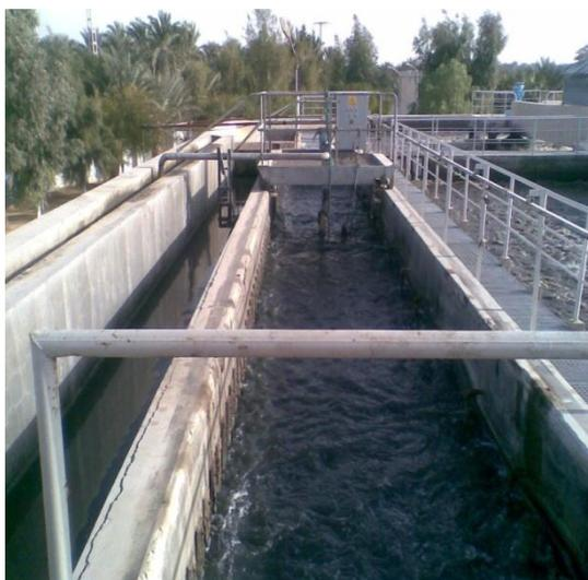
**I.2.4. Le bassin d'aération :** l'eau est répartie dans deux bassins d'aération rectangulaires. L'apport en oxygène est assuré par 04 turbines d'aération, l'eau aérée est transférée vers les deux décanteurs à partir de deux goulottes installées latéralement.
