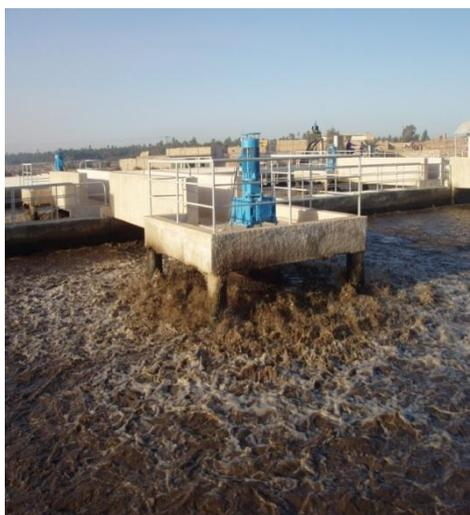
**I.2.5. Décanteur secondaire :** l'eau décantée est évacuée par des lames déversantes crantées disposées réglementé sur le pourtour du bassin de décantation. L'eau se déverse dans une goulotte circulaire qui débouche dans un puisard au bassin de chloration.
