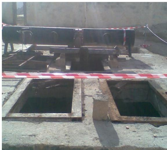
**I.2.2. Le Dégrillage :** il consiste à faire passer les eaux usées au travers d'une grille dont les barreaux, plus ou moins espacés, retiennent les éléments les plus grossiers. Après nettoyage des grilles par des moyens mécaniques, manuels ou automatiques, les déchets sont évacués avec les ordures ménagères. Le tamisage, qui utilise des grilles de plus faible espacement, peut parfois compléter cette phase du prétraitement. (BENZAOUIN, ELBOUS F, 2009).
