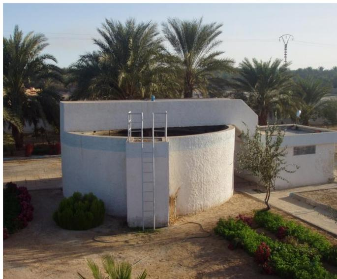
**I.2.9. Les lits de séchage :** après épaississement, les boues sont transférées vers les lits de séchage par une pompe. Les boues expansées à l'air libre subissent une double déshydratation : par percolation interstitielle (drainage) et évaporation. Au bout d'un temps qui peut être plus ou moins long (en fonction de la température et de l'humidité).
