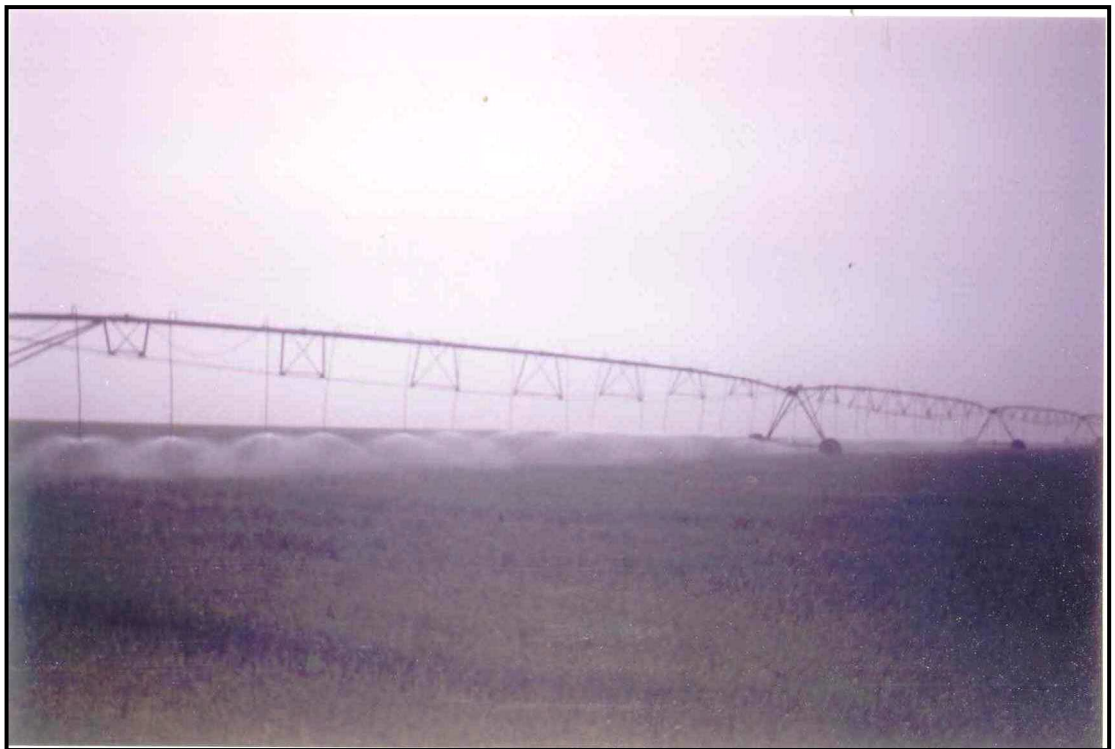
Figure 04: Pivot au moment d'irrigation Station ERIAD
