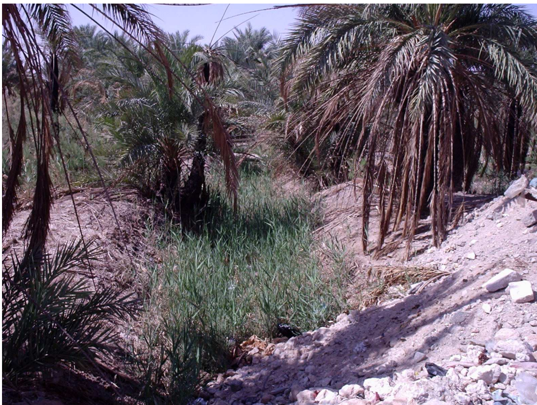
Photo N°12: L'envahissement des drains par les mauvaises herbes
