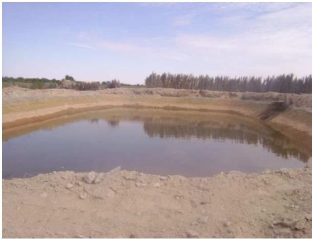
Photo N°15 : Bassin traditionnel pour l'accumulation de l'eau(Hassi Ben Abdallah)
