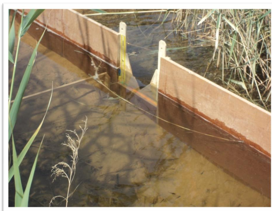
Photo- III.18– Fixation de déversoir entrée
