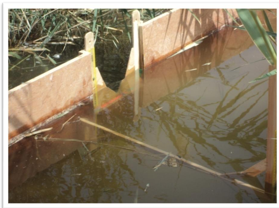
Photo- III.19– Fixation de déversoir sortie
