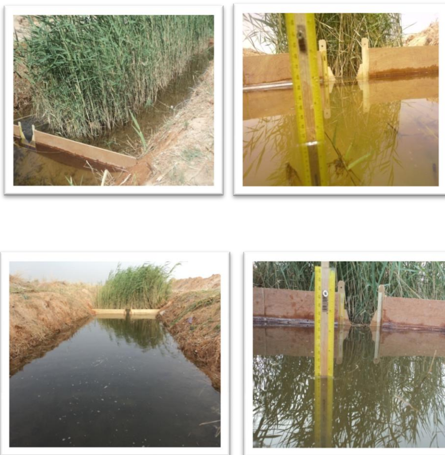
Photo- III.23– Variation de hauteur d'eau dans déversoir.
