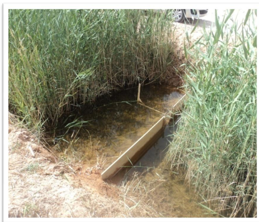
Photo- III.20- Aménagements de l'emplacement de station
