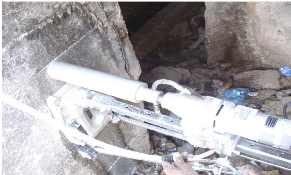
Photo II : Opération de carottage (II -a)
