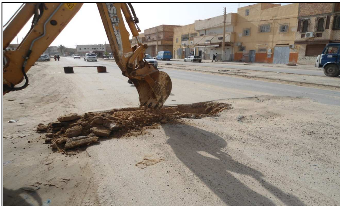
Photo I : Préparation pour prendre les carottes (a)
