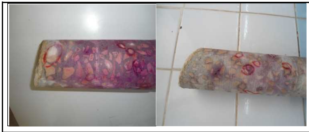
Photo (III, 13): Front de carbonatation révélé par le test à la phénolphthaléine.
