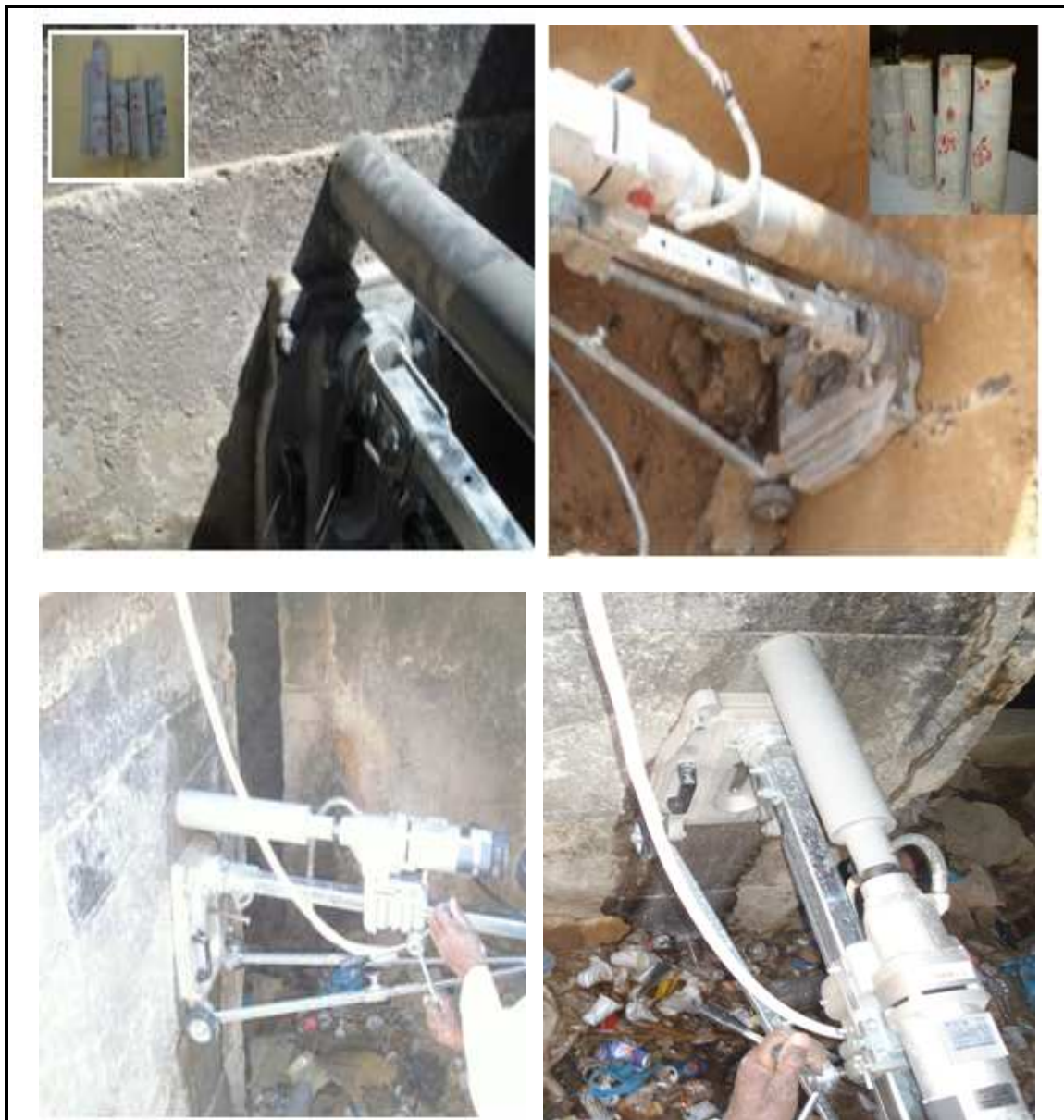
Photo (III, 12):Prélèvement des échantillons de la galerie.
