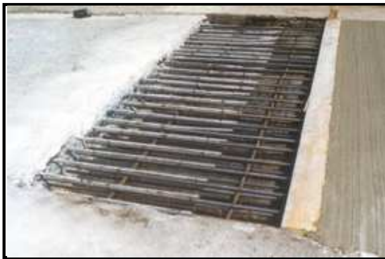
Photo (IV, 2): Détail d'une réparation et remplacement des armatures.
