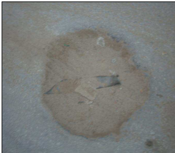
Photo XVIII: Regard sous goudron et plein de sable en surface.
