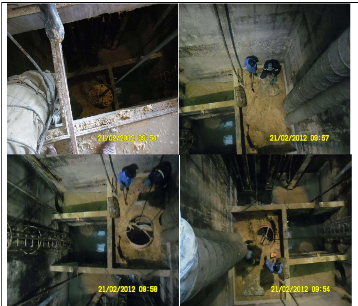
Photos XIV : Opération d'entretien de la bache d'aspiration de la station de pompage d'Ain Bieda.
