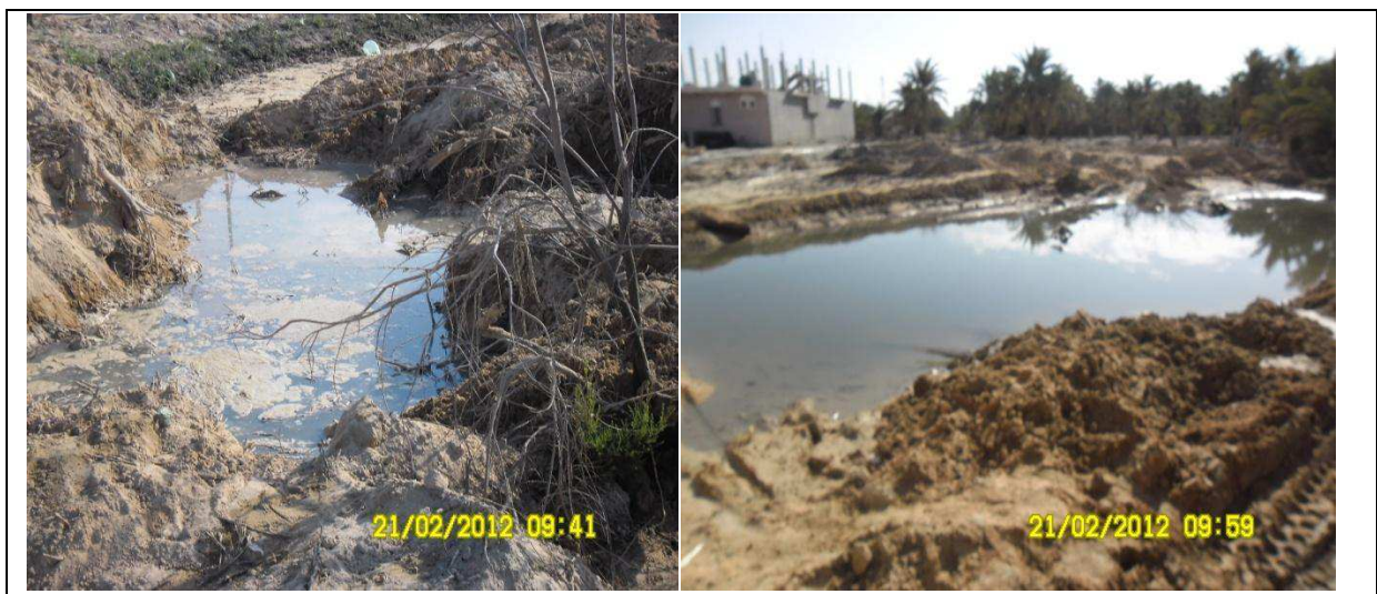
Photos XII : Débordement des eaux usées près de la station de pompage Ain Beida.
