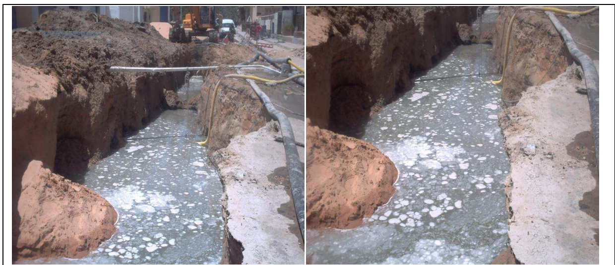
Photos VII : L'état de reconstruit à l'aval de collecteur BO avec la présence de la nappe dans les tranchées à Sidi Bougoufala.
