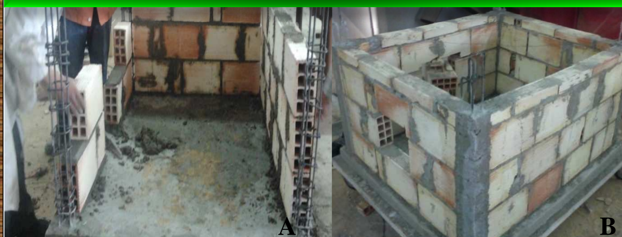
Coffrage et Coulage des poteaux
