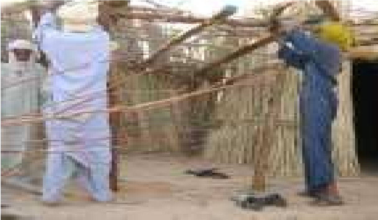
الصورة رقم 2: كيفية بناء الزريبة
