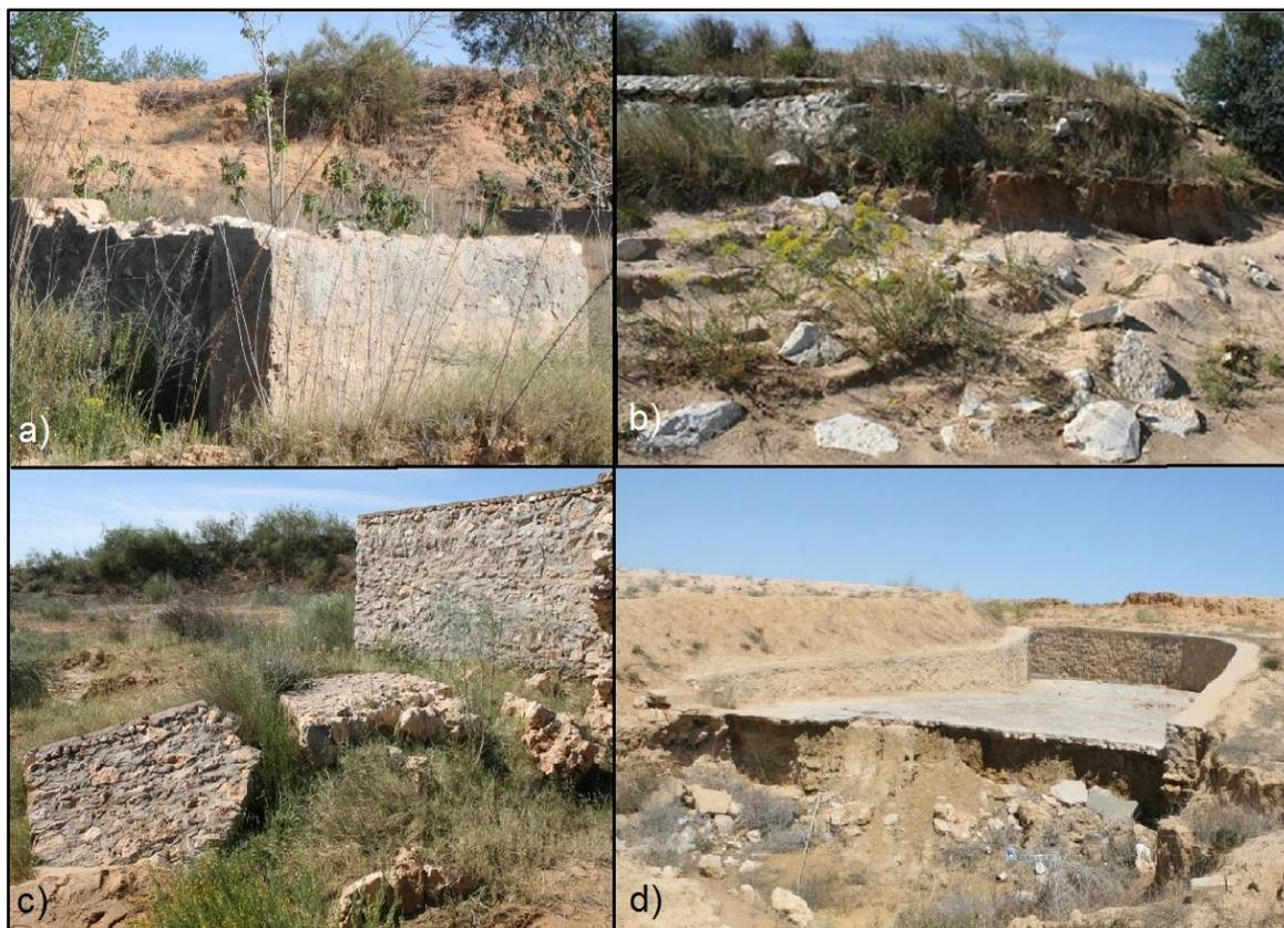
**Figure 6.-** Exemples d'ouvrages anti-érosifs dégradés (a : épis, b : ouvrage en pierre, c : seuil et d : évacuateur de crue)
