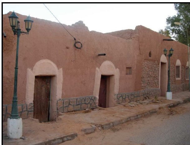
Photo n° 5. Maison restaurée dans le ksar de Taghit (nouveau propriétaire algérois)
