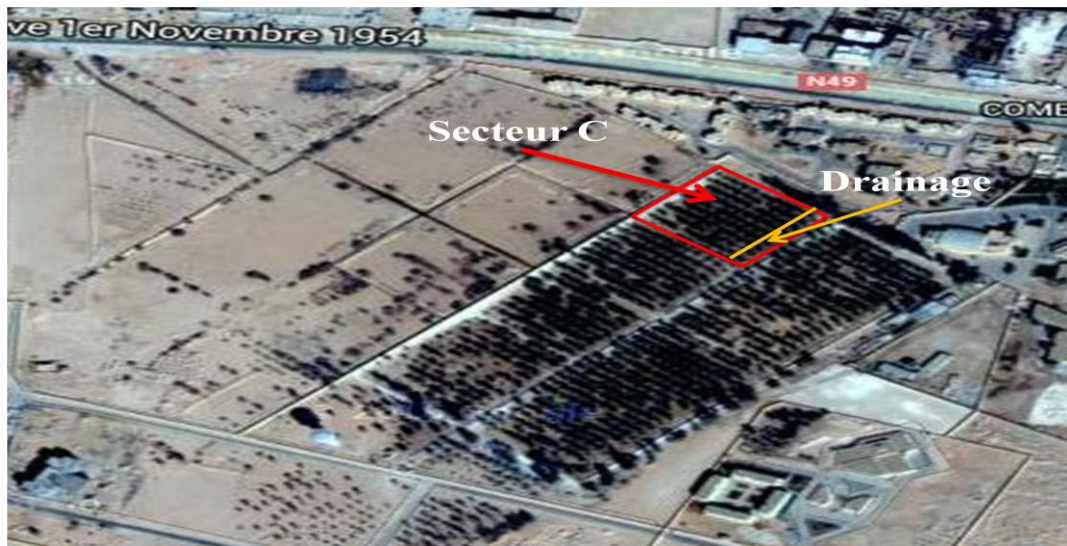
Figure 04 : Présentation de l'eau de drainage dans un drain de la ferme de l'université d'Ouargla.
