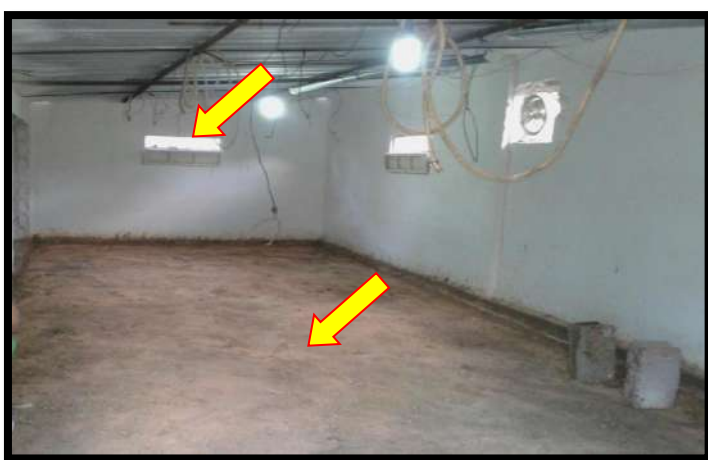
Photo N 11 : Sol nu, ouvertures insuffisantes
