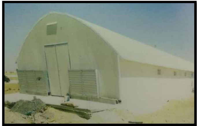
Photo N 02 : Bâtiment avicole moderne type clos
