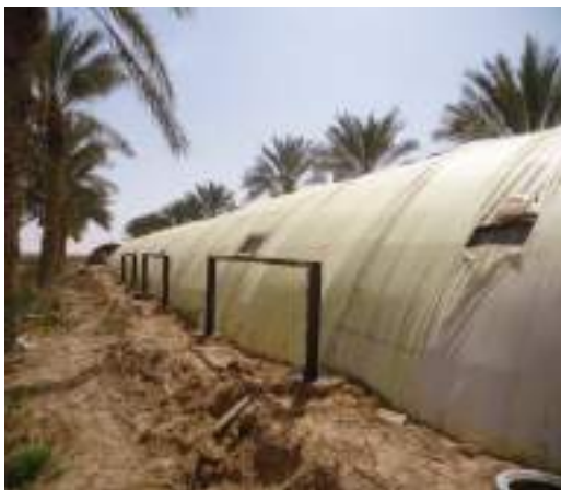
Photo N° 02 : Vue du bâtiment N° 02 datte de démarrage 1998
