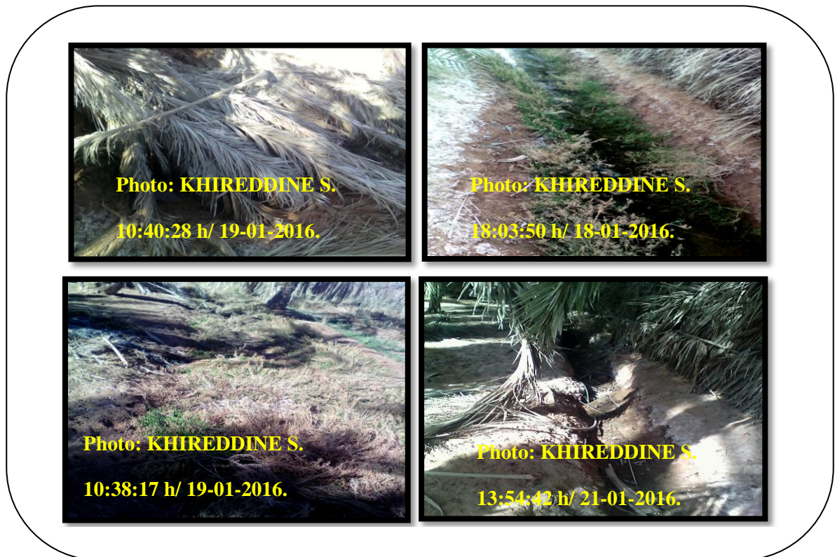
Figure 32 : Etat des drains
