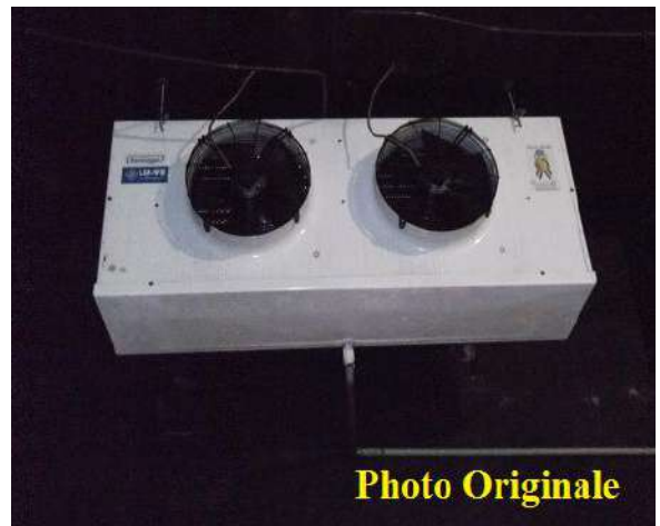
Fig. 41 : Réfrigérateur de la chambre froide (Usine 02, 2016)
