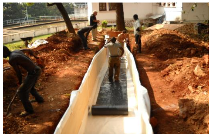
Figure 2a : Tranchée dans laquelle a été construit le pilote ;
