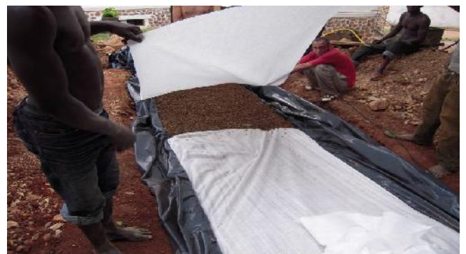
Figure 2b : Mise en place des matériaux filtrants sable 4/8 ; 0/4 séparé des granulats 20 par du géotextile
