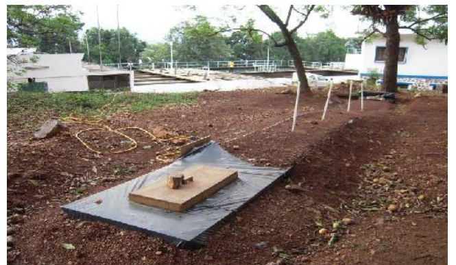
Figure 2c : Vue du pilote terminé (trappe d'alimentation, les 4 piézomètres et la réception) ;
