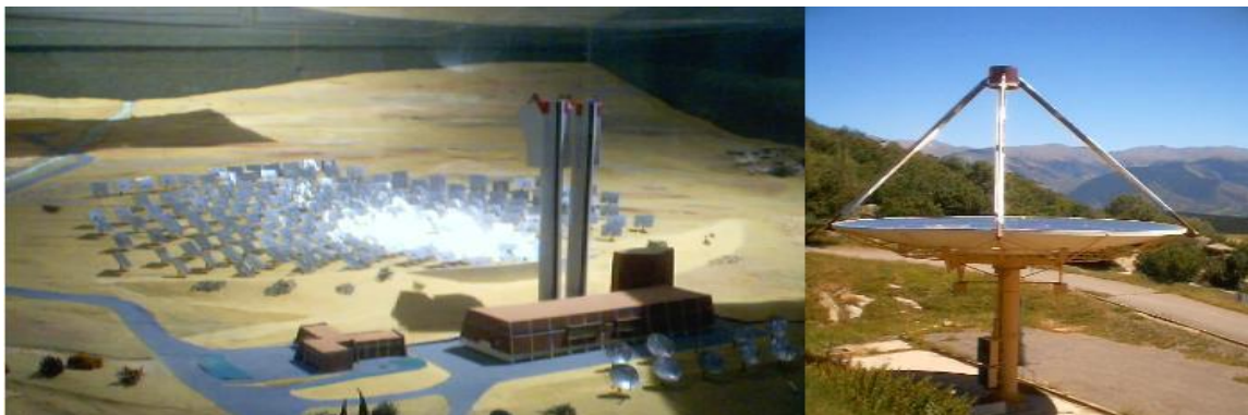
Figure (I.14) : Champ d'héliostat -centrale solaire Thémis France.
