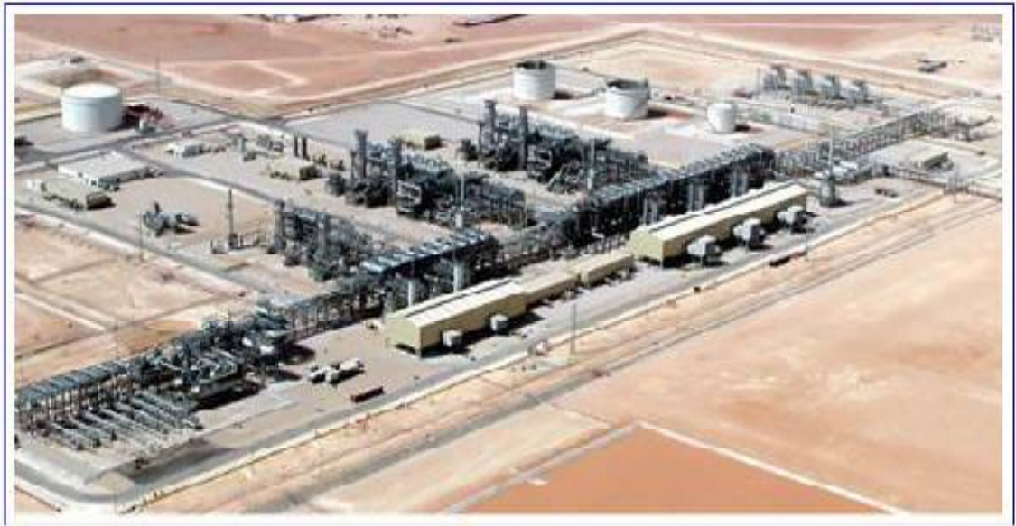
Fig. I.3 : Vue globale de l'usine de traitement de gaz d'Ohanet.
