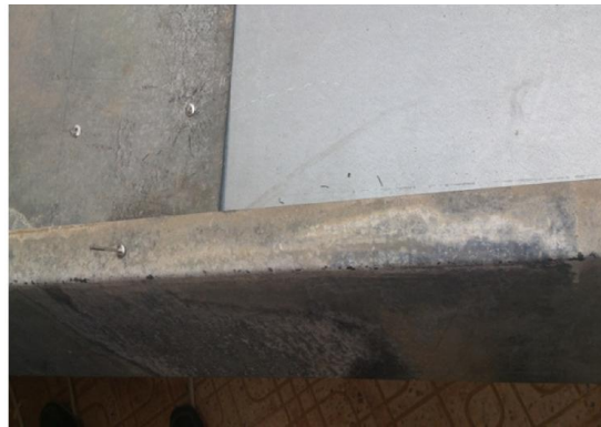
Figure (A.B.3): Trouer et collage des plaques
