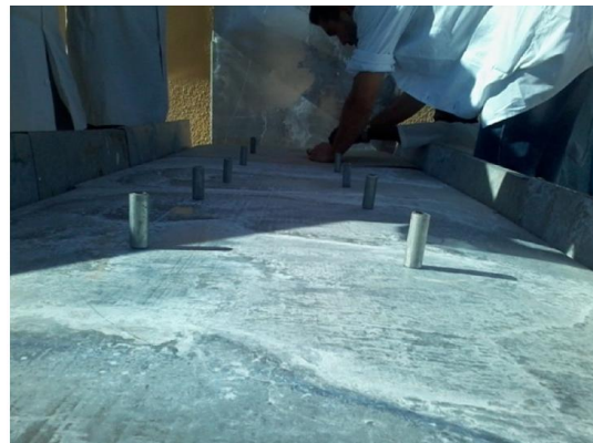
Figure (A.B.4) : Coller l'isolant sur le couvre et fixation des plaques (les capteurs)
