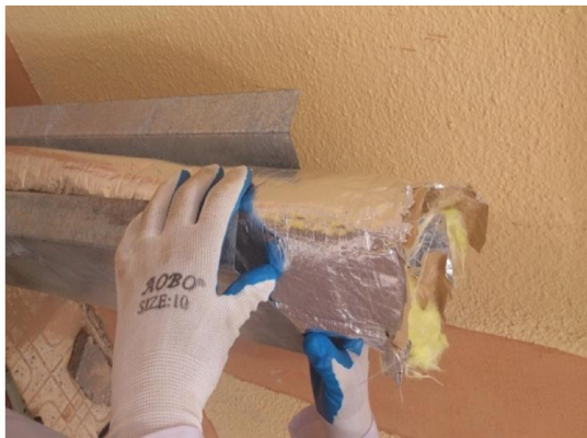
Figure (A.B.4) : Coller l'isolant sur le couvre et fixation des plaques (les capteurs)
