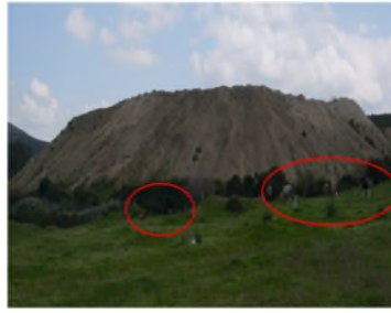
Figure : 3 – Digue à scorie
