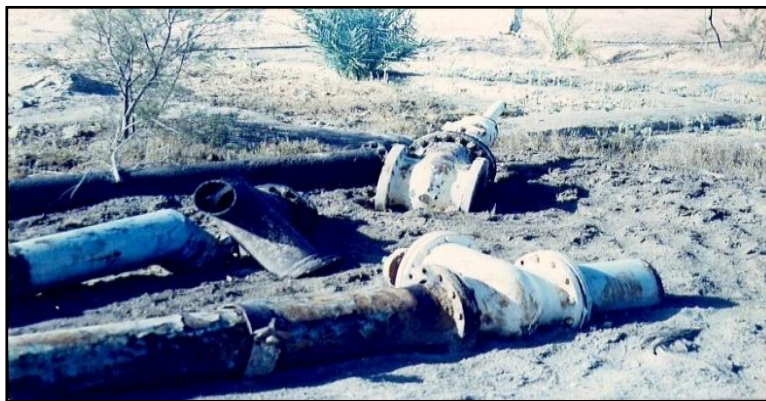
Fig.24 : Photos présentant l'état de la tête du forage Albien et ses annexes à Sidi Mahdi.
