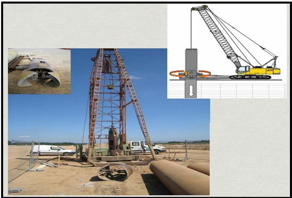
Fig. 26 : Sonde de forage par Battage.
