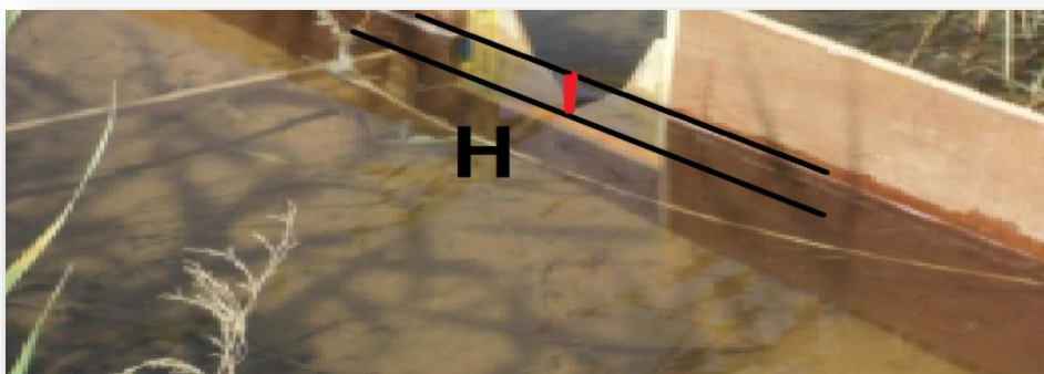
Figure 29: L'installation de panneaux
