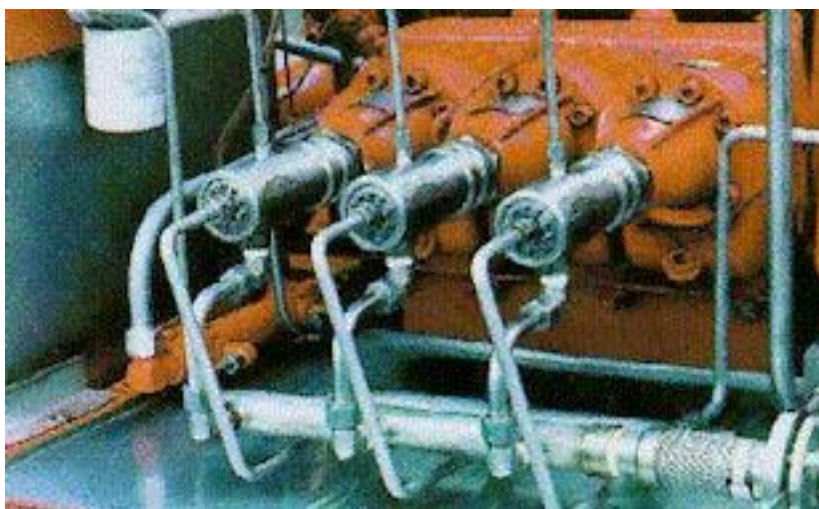
Fig II.5 : Pompe de Refoulement.
